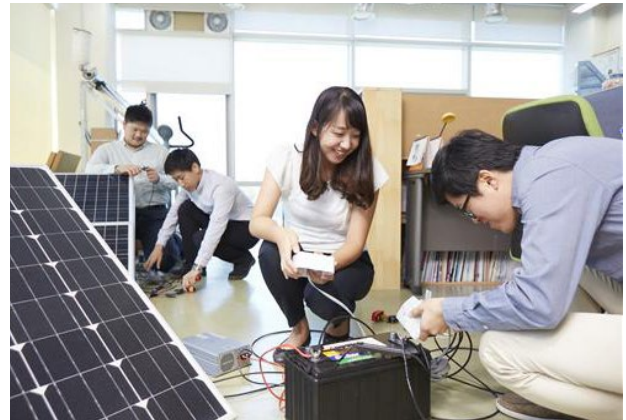
태양광에너지 설치 과정
