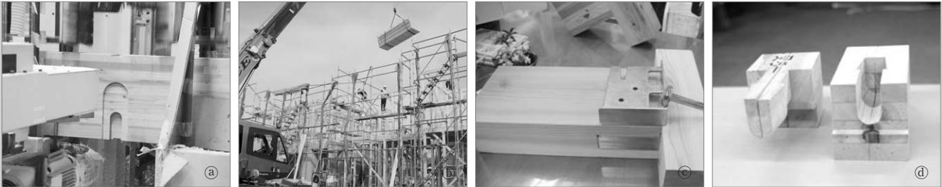
그림 9 : 현대적 목조건축 방식의 사례 ①: precut공장에서 치목 ②: 중장비로 양중 ③: 접합부 철물보강 ④: 접합부 간이화
