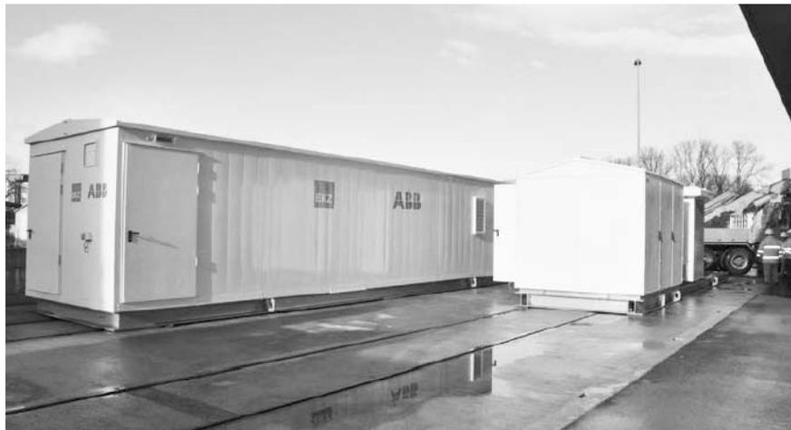
〈그림 4〉 LG화학이 스위스 전력회사인 EKS에 ABB와 함께 공급한 Grid용 ESS. 그림 좌측의 컨테이너에 500kWh의 리튬이차전지와 공조시스템이 들어있고, 우측 컨테이너는 전력변환시스템임.
